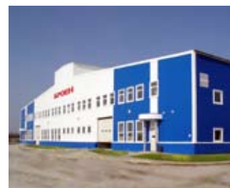
Производственный комплекс BROEN в Коломне
